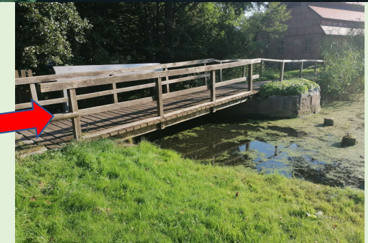
Wehrbrücke (oben im Vordergrund das Wehr)
